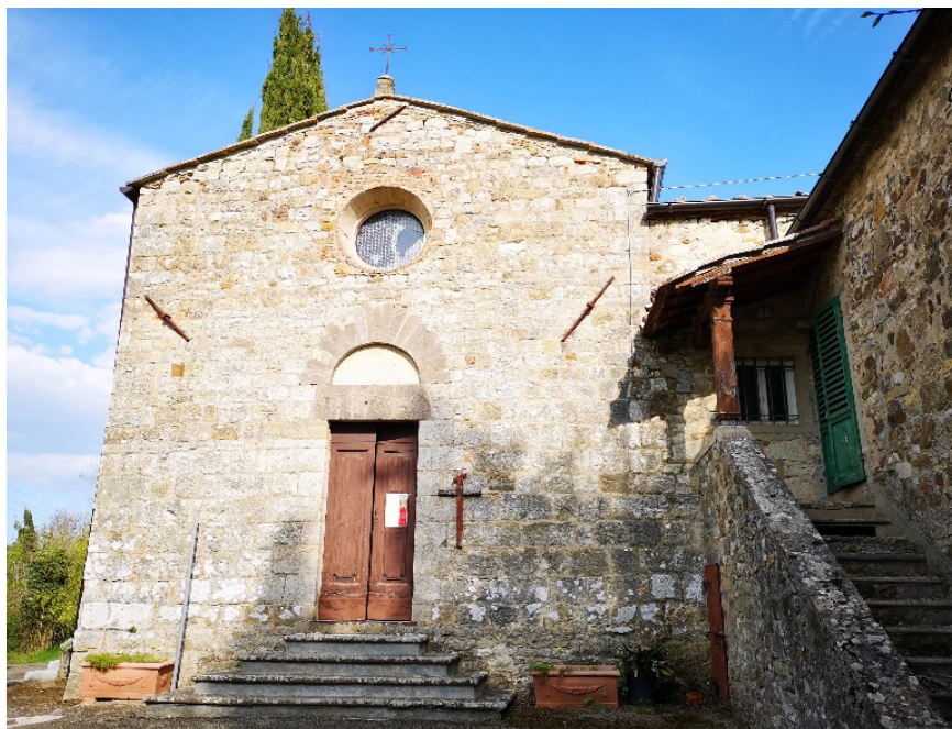
Fig. 24. Facciata della chiesa di S. Giorgio alla Piazza
