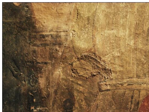
Foto 29. La luce radente evidenzia una stuccatura in cemento.
