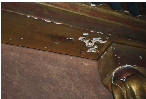
Foto 11. Fori e danneggiamenti sulla cornice lignea.
